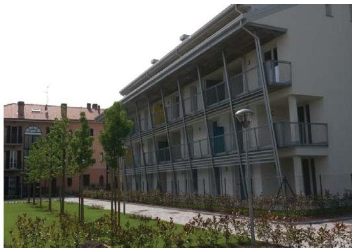
Lato Sud edificio in Via Silla 124, Milano
